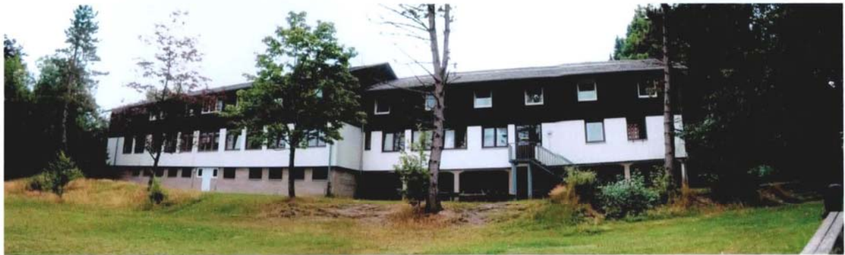
rückwärtige Ansicht des gesamten Gebäudes (von Nordwesten)
